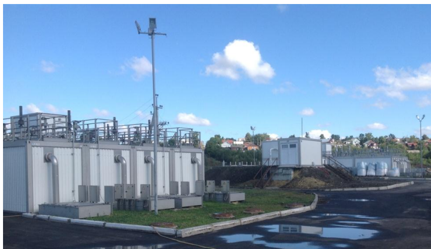
Модульные очистные сооружения канализации г. Аткарска
