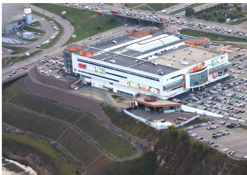
Современное состояние оползневого откоса у ТРК «Июнь» в г. Красноярск
